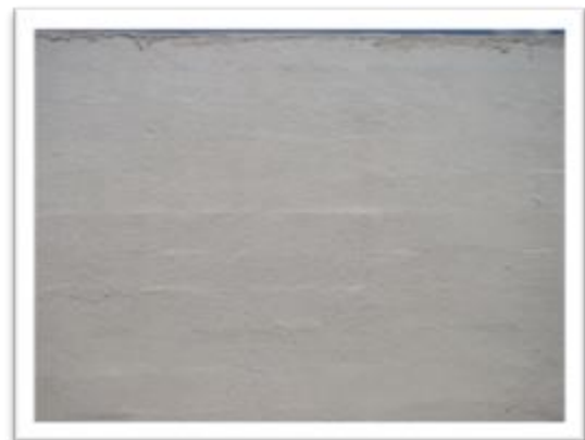
Textura aplicada diretamente sobre o tijolo – imperfeições aparentes.
