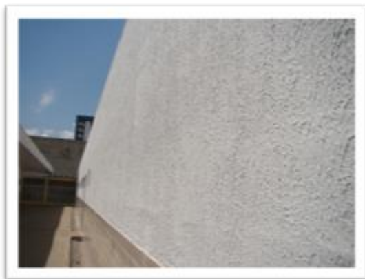
Textura aplicada diretamente sobre o tijolo – imperfeições aparentes.
